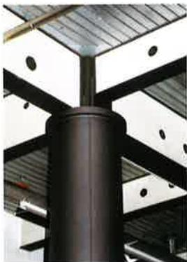
Fig. 20: Poutre à âme enrobée de béton sur poteau en profil creux rempli de béton
