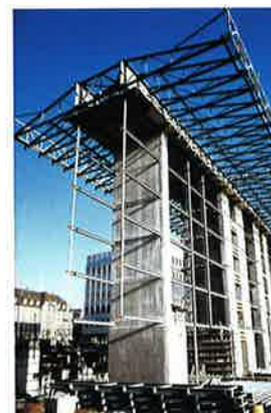
Fig. 29: Bâtiment commercial à Lausanne avec poteaux de façades suspendus. Dans les bâtiments réellement suspendus, où les poteaux de façade ne peuvent transmettre aucune force vers le bas, la structure de suspension doit également être protégée contre le feu dans le dernier étage.
