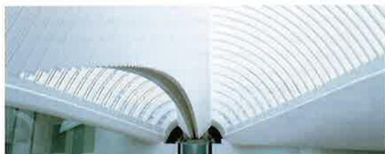
Fig. 12: Dôme de l'université de Zurich: profils en caissons recouverts de peinture intumescente R 30
