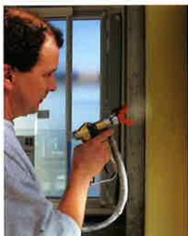
Fig. 9: Application au pistolet sur un pilier de façade en profil creux (Max Schweizer AG)
