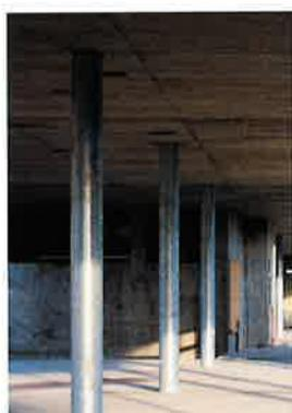
Fig. 22: Poteaux anti-feu (Tuchschmid-Atlant) dans un garage souterrain
