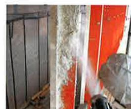
Fig. 19: Application de crépi par projection au pistolet sur les poteaux de façade en té, Bâtiment de la Poste à Fribourg
