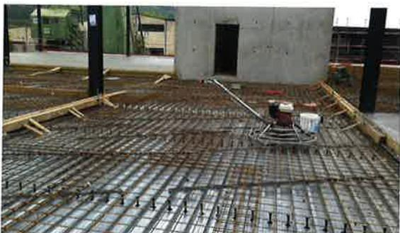
Fig. 44: Dalle mixte acier-béton avant le bétonnage
