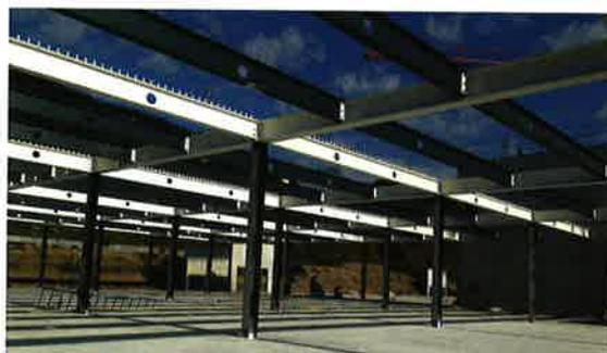
Fig. 42: Structure porteuse en acier: poutres blanches avec peinture intumescente
