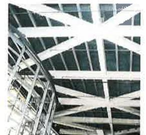
Fig. 15: Structure en treillis d'un bâtiment d'expositions, revêtements anti-feu (Promat AG)
