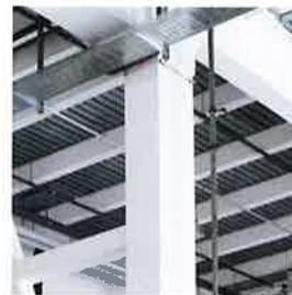
Fig. 14: Hangar d'usine à Dietikon, revêtements anti-feu (Rigips AG)
