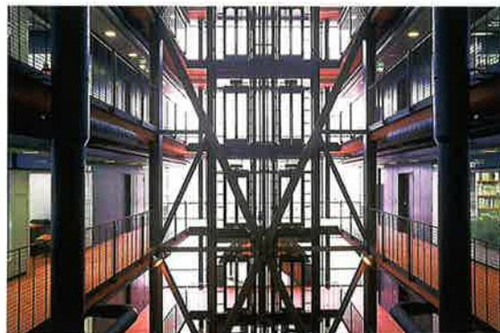
Fig. 6: Structure porteuse en acier non protégé, Bâtiment administratif Arcelor Long Commercial, Differdange, Luxembourg
