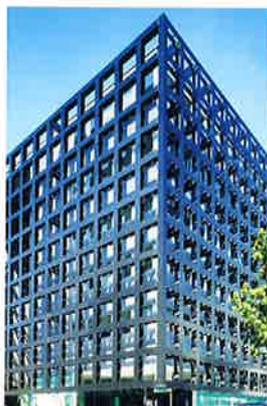
Fig. 35: La Ferriera, bâtiment administratif de 5 étages à Locarno, avec structure porteuse extérieure (Prix acier 2005)
