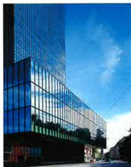
Fig. 11: La Tour de la Foire de Bâle: Peinture intumescente R 60 de la structure porteuse des deux niveaux largement en saillie; dans la tour, revêtements conventionnels par plaques R 90 ainsi que des poteaux mixtes.
