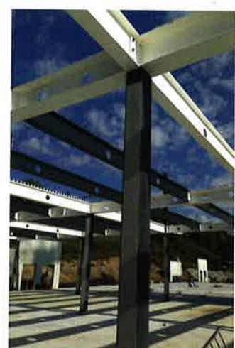
Fig. 43: Structure porteuse en acier: détail de l'assemblage du nœud
